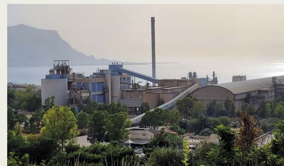
Cementeria di Isola delle Femmine (PA)
