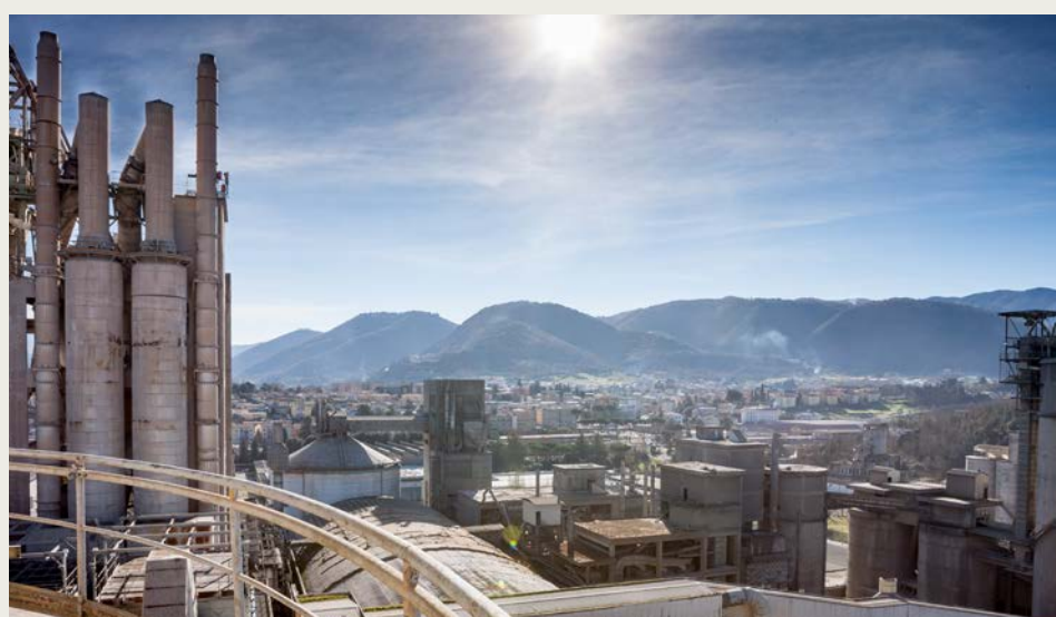
Cementeria di Colferro (RM)
