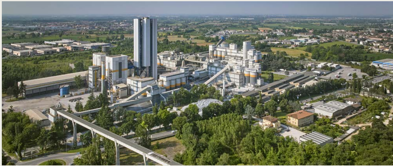
Cementeria di Rezzato-Mazzano (BS)
