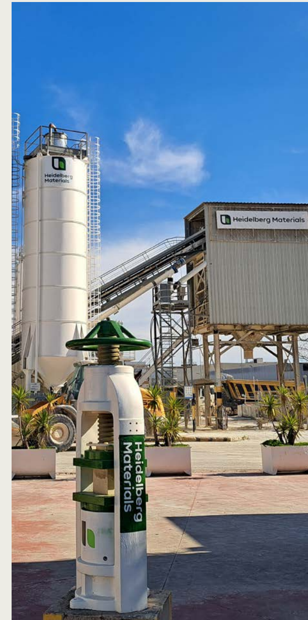
Impianto di calcestruzzo di Bari (BA)
