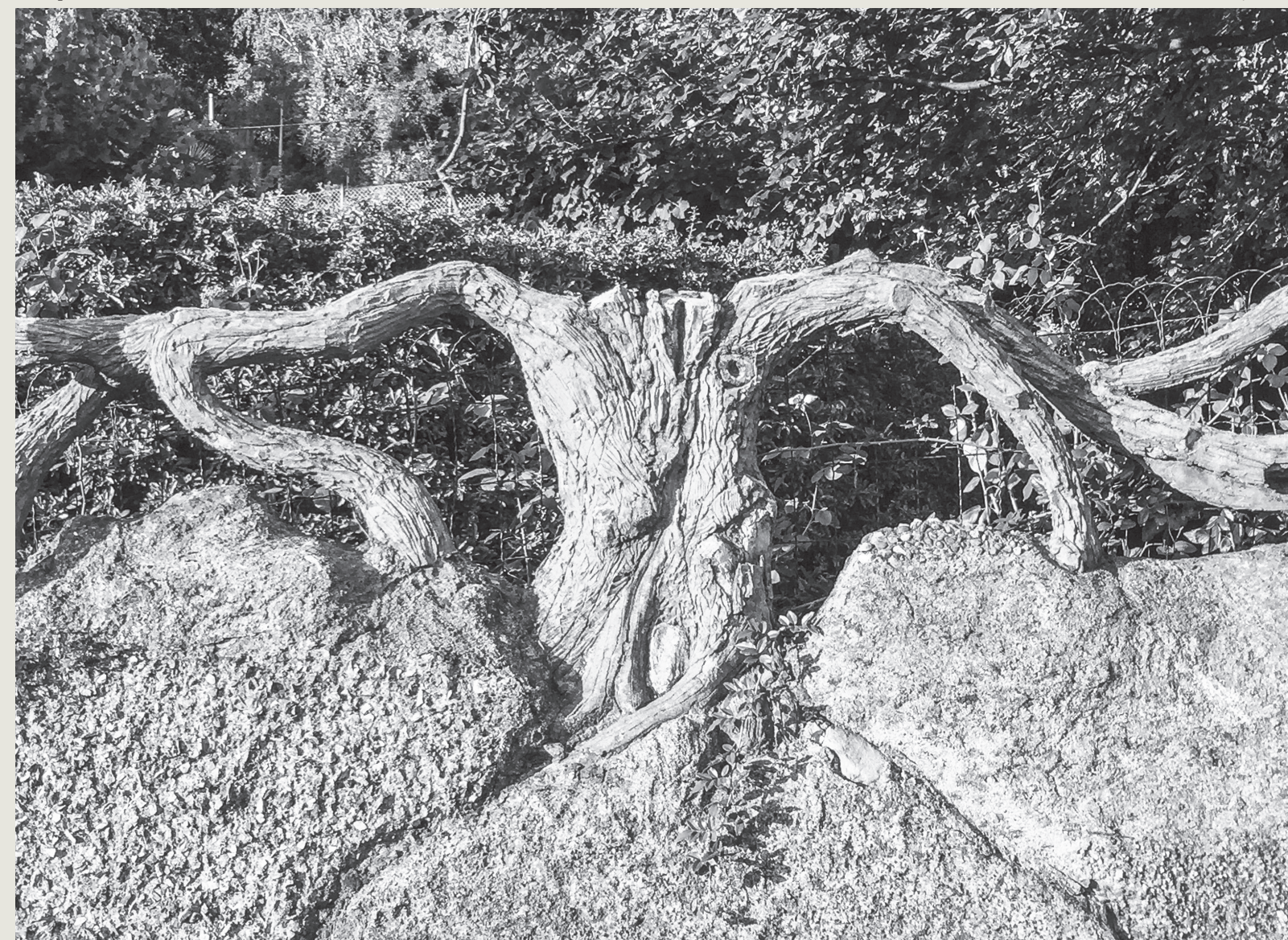
Gianluca Gelmini, parco di Villa Brambilla a Calolziocorte, Lecco (Arch. Bialetti, 1914), particolare del muro di recinzione in cemento.
