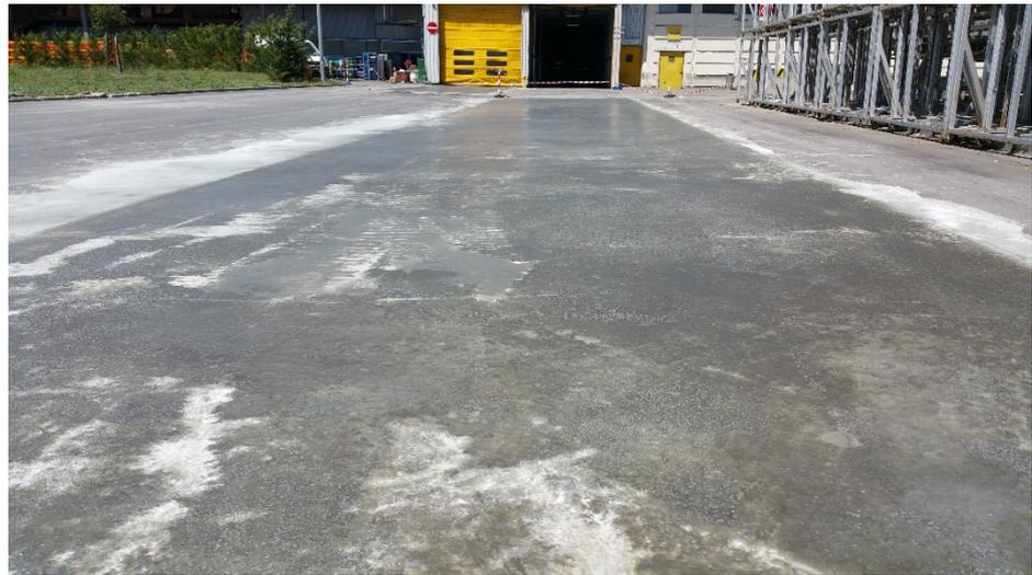
Intasamento con i.tech CARGO di circa 2.700 mq di pavimentazione all'interno dello stabilimento **Fiat** di Melfi. Il lavoro di ripristino del piazzale prevedeva l'intasamento della superficie in quanto serviva una pavimentazione durevole nel tempo al passaggio di mezzi operatori pesanti e con ruote in ferro.
