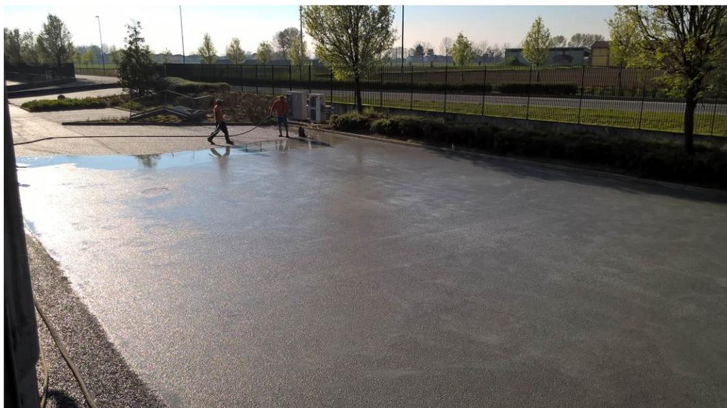
**Figura 7 – Intasamento dell'asfalto**
