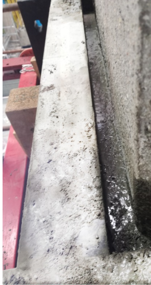
Fig 7: Particolare del rinforzo in calcestruzzo fibrorinforzato con spessore di 3 cm.
