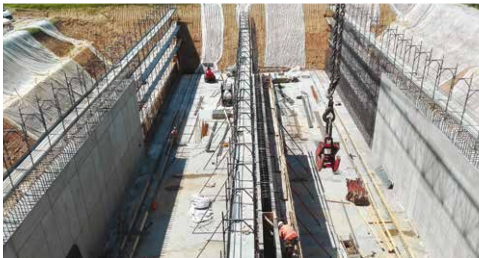
7. La realizzazione dei setti per l'esecuzione del monolite nella fase 0
