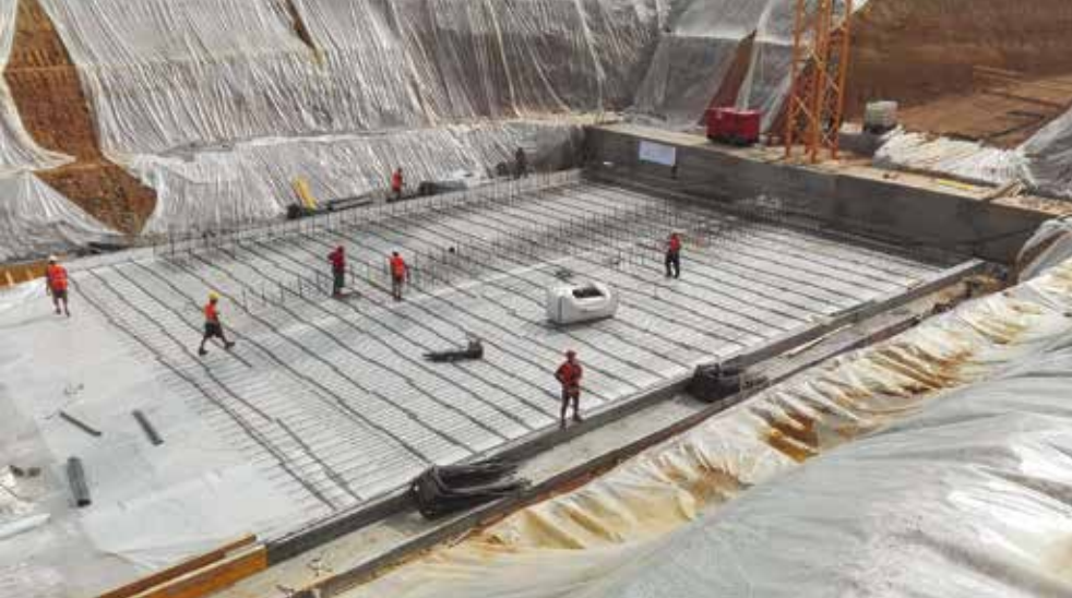
3. La posa dell'armatura del solettone di base per la realizzazione del monolite nella fase 0
