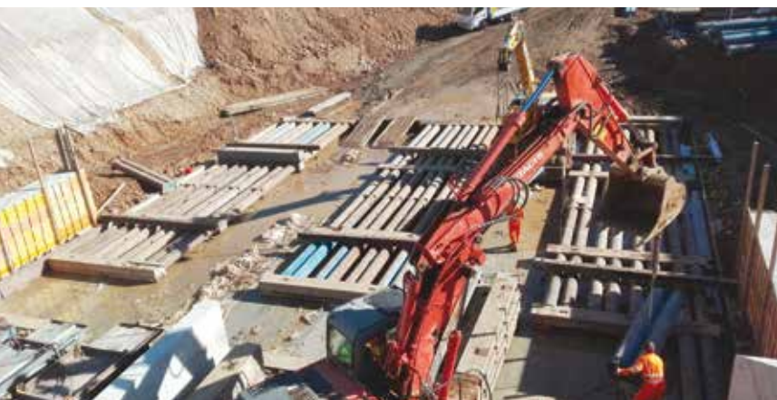
2. La posa delle prolunghe per i martinetti idraulici durante l'attività di spinta della seconda fase
