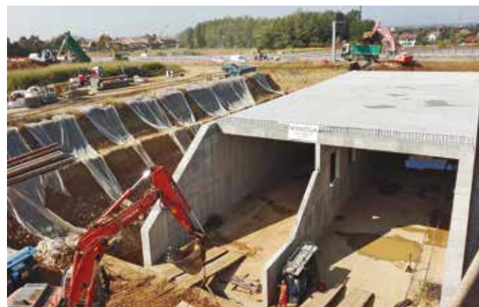
4. La posa dei martinetti idraulici durante l'attività di spinta della prima fase
